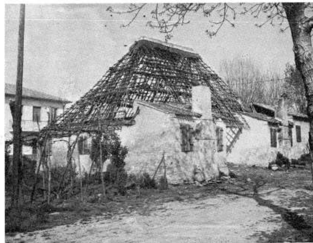
Ecco com'era strutturato il tetto di un casone
